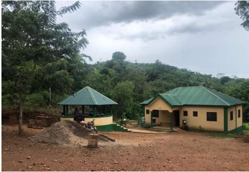
A Dunyo, il a fallu réaliser un nouveau dispensaire, plus accessible notamment.....
